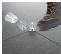
RIMOZIONE: calciare il tirante lungo le direttrici delle fughe. REMOVE: kicking the clip in the direction of the joint. ENLEVEZ: en vissant le tirant avec plus de force ou en lui donnant un coup de pied dans le sens du jointement. ENTFERNEN: die Zugstange mit einem größeren Druck drehen oder sie in der Fugenrichtung kicken.
